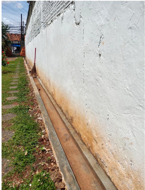
**11** Pembuatan saluran air keluar di bawah paving block di belakang gerbang utama.
